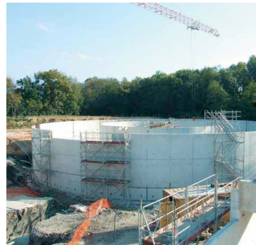
La station d'épuration en cours de construction
