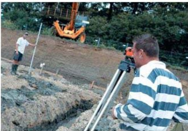
Un chantier à Saint-Georges-sur-Baulche
